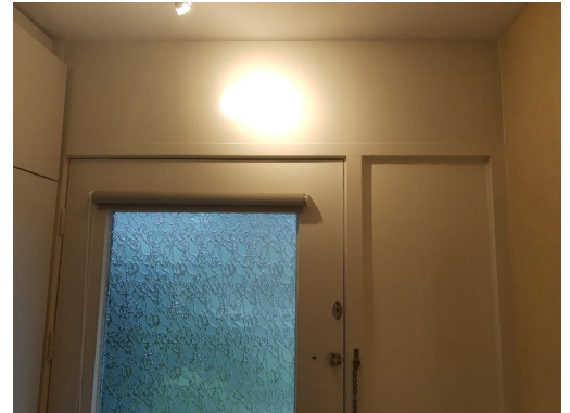
Eindresultaat na isoleren spouw en verwijderen verlaagd plafond
