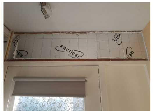
De PIR isolatieplaten van 60mm dik
