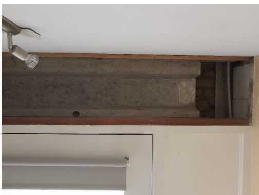
Op deze foto is duidelijk te zien dat de betonnen luifel voor een deel in de spouw aanwezig is
