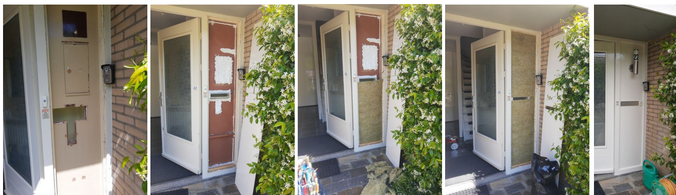
Bestaande opbouw gevel, Achter de 2 e bruine plaat is een nieuwe spaanplaat brievenbus/meterkast te zien. Dit is dus NIET de originele kast
