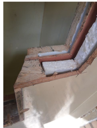
Bestaande opbouw gevel, Achter de 2 e bruine plaat is een nieuwe spaanplaat brievenbus/meterkast te zien. Dit is dus NIET de originele kast
